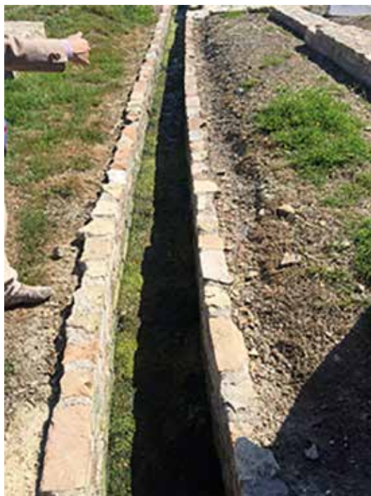
Resti di un antico canale di scolo presso un edificio romano nel porto di Classe
